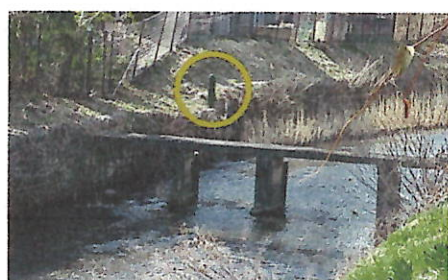
熊川分水取水口
